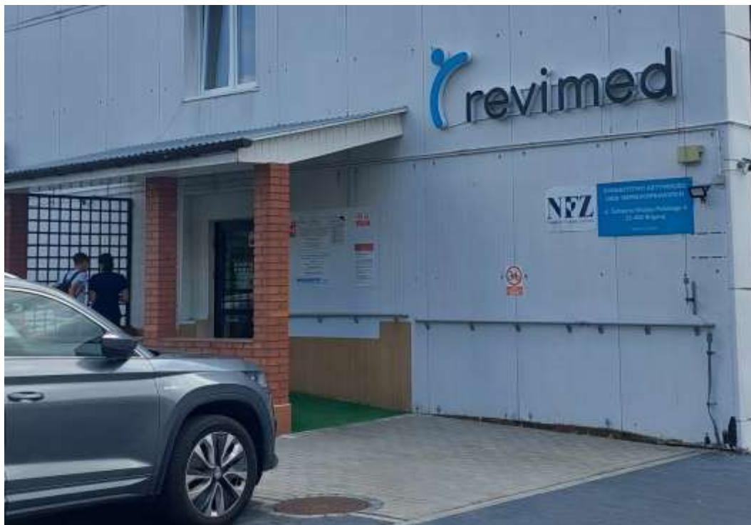
Rys. 122. Siedziba Towarzystwa Aktywności Osób Niepełnosprawnych – wejście do Przychodni Rehabilitacyjnej REVIMED
