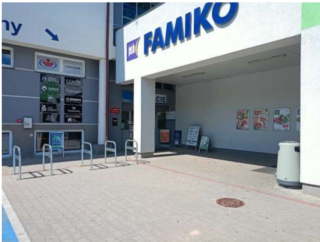
Rys. 308. Lubelska siedziba Fundacji Centrum Niepełnosprawnych Przedsiębiorców
